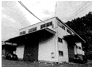
新「ノボル鋼鉄静岡支店 藤枝出張所」
